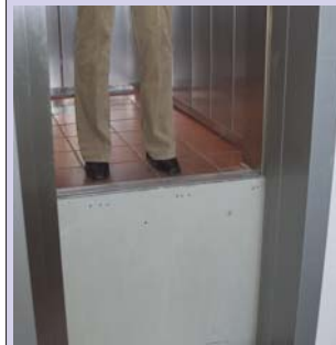
Je nach Örtlichkeit ist eine massive oder eine Teleskop-Fahrkorbschürze erforderlich.
